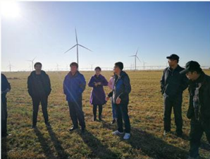
泰来县风电一期项目现场检查
