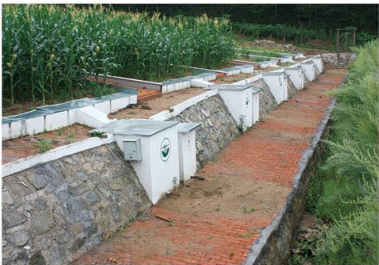
牡丹江麻花沟坡面径流观测场
