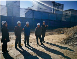
泰来县生物质热电项目现场检查
