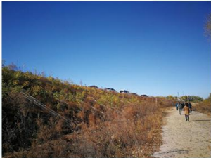
齐北线齐富段增建二线项目现场检查
