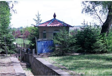
宾县孙家沟小流域控制站
